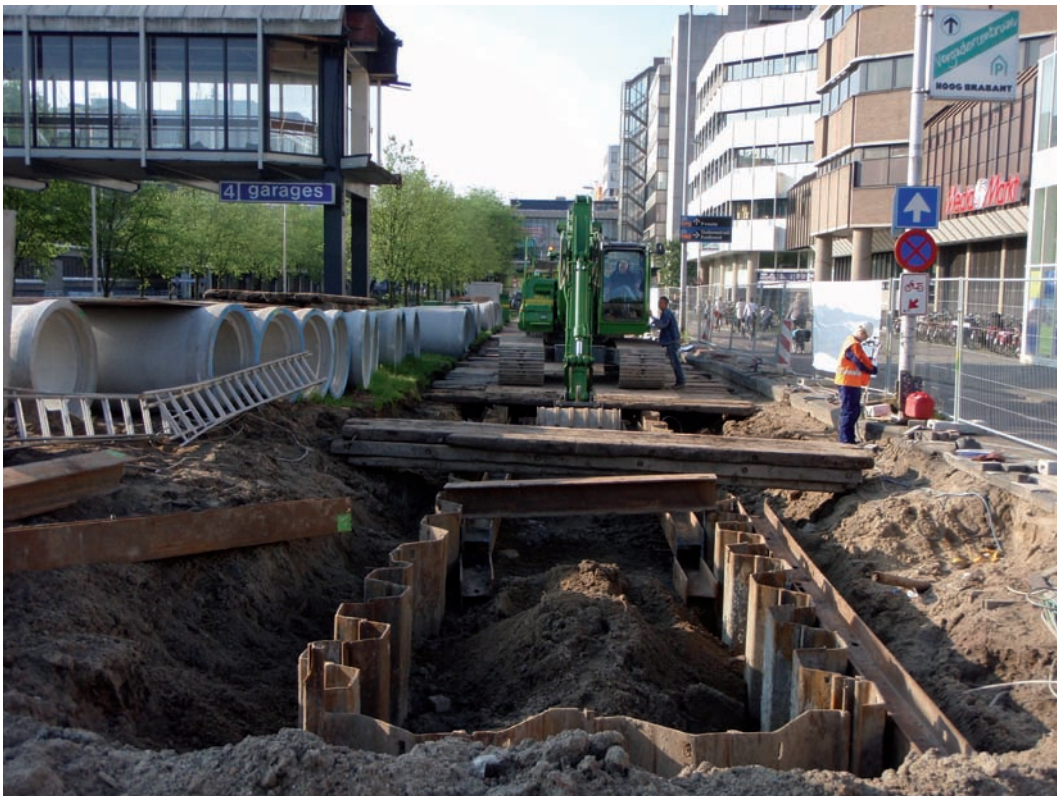
Afb. 2. De ligging van de rioolsleuf bij aanvang van het onderzoek.
